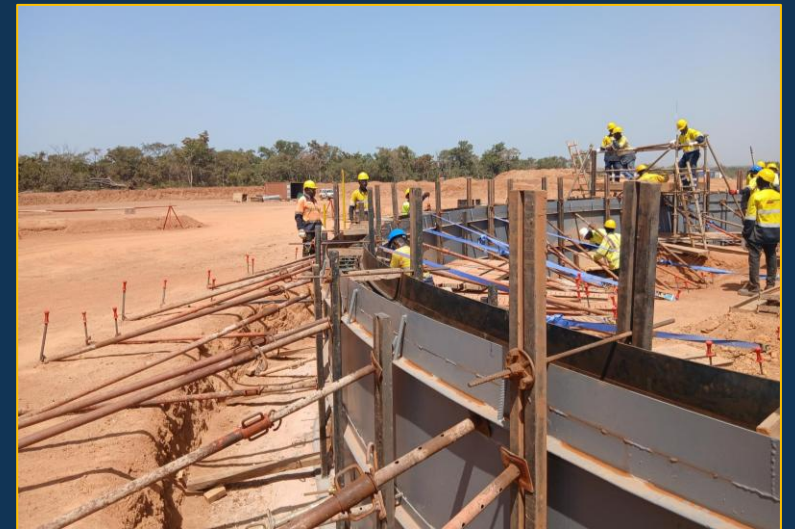
(R) Concrete pour on CIL Tank No. 8 Ring Beam
